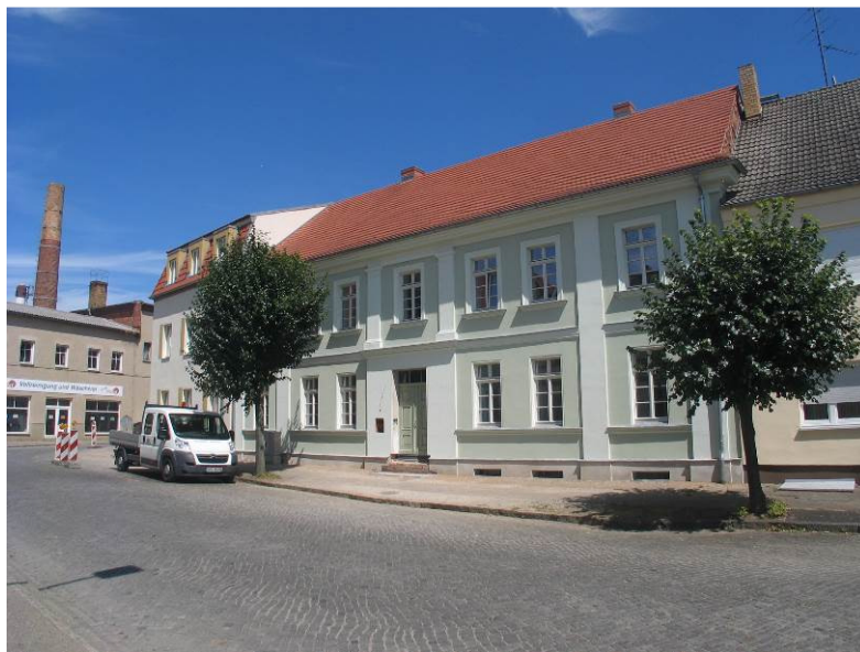
Die Wohnhäuser Klosterblick nach der Sanierung Rainer Lehmann, ews StadtSanierungsgesellschaft mbH
