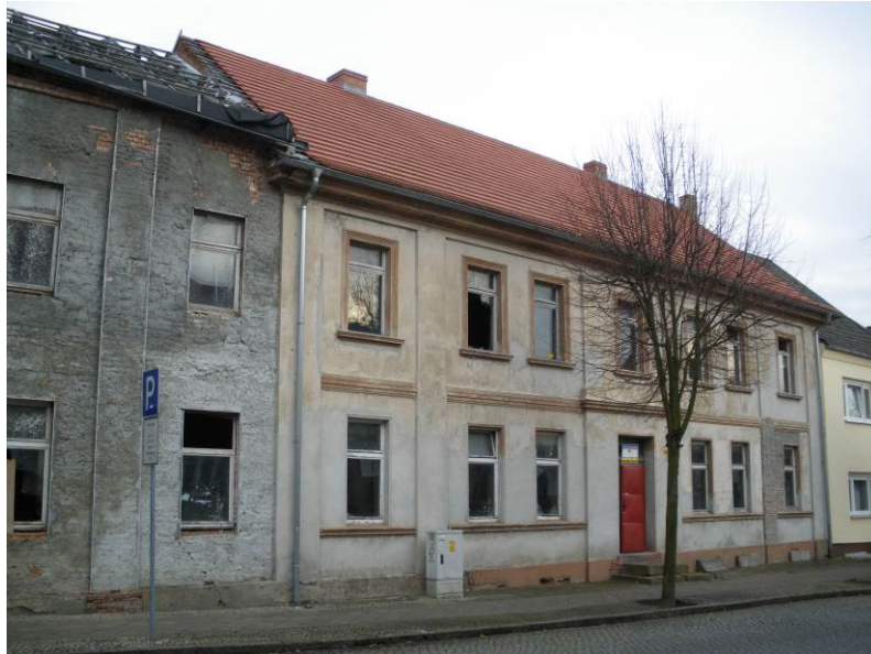
Die Wohnhäuser Klosterblick vor der Sanierung Rainer Lehmann, ews StadtSanierungsgesellschaft mbH
