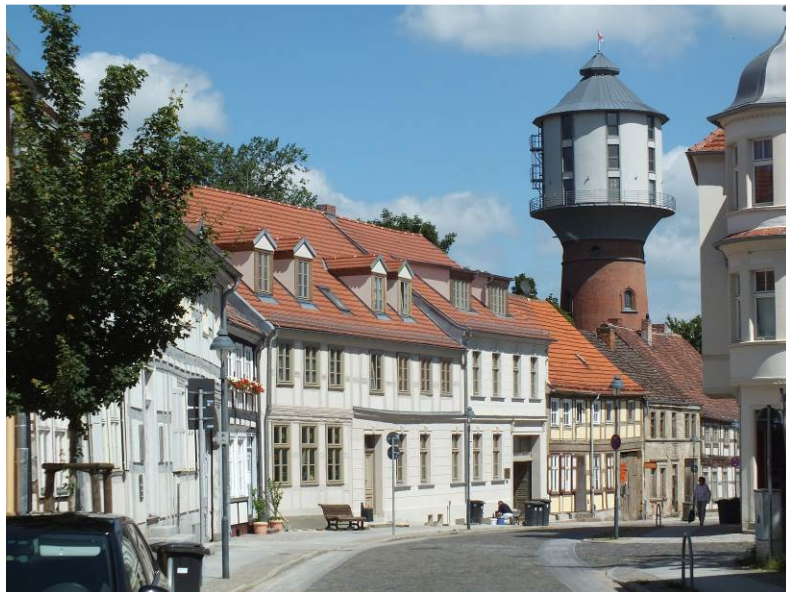
Die Goethestraße nach der Sanierung im Jahr 2013.
