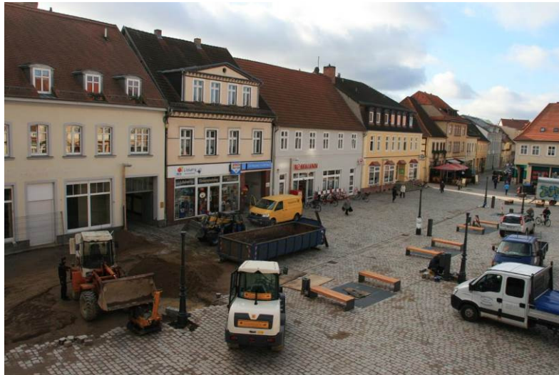
Der Wittstocker Markt während der Sanierungsarbeiten.
