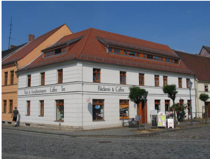
Markt 17 nach der Sanierung mit Blumenladen und Bäckerei mit Café Rainer Lehmann, ewS StadtSanierungsgesellschaft mbH
