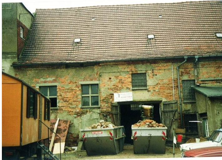
Das Gebäude am Klosterhof vor der Sanierung. Amt Dahme/Mark
