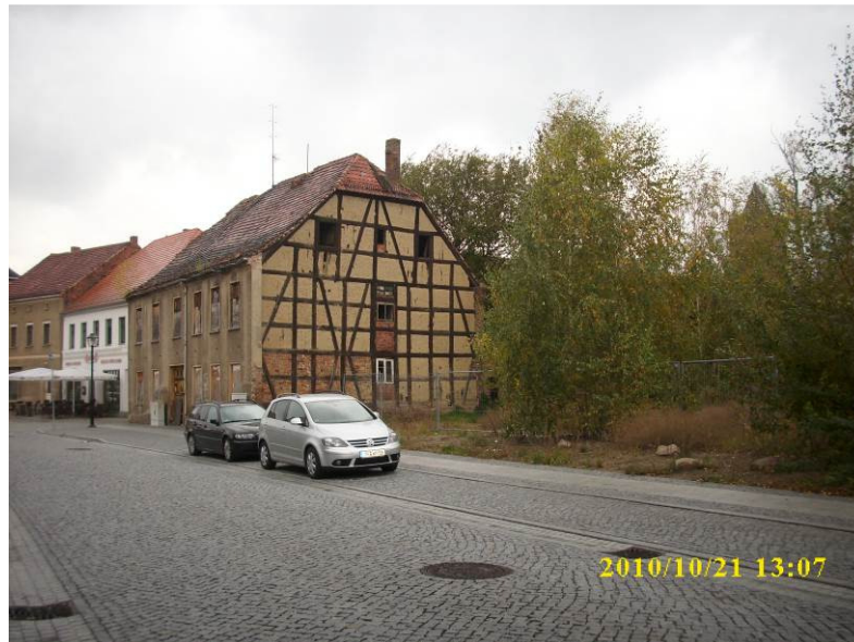
Das Gebäude Planeberg 1 vor der Sanierung.
