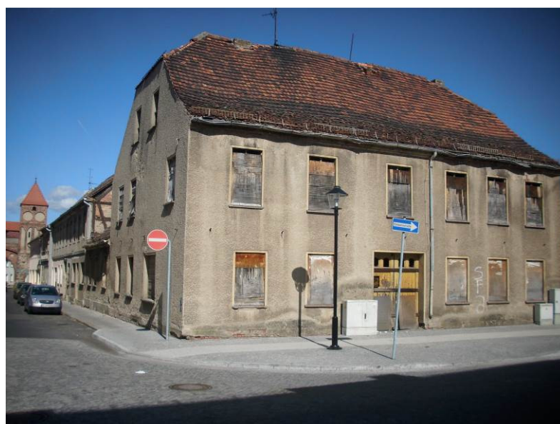
Das Gebäude Planeberg 1 vor der Sanierung.
