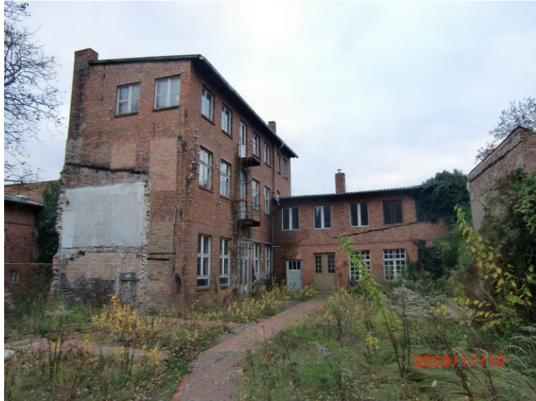
Der Hofbereich Uchtenhagenstraße 3 vor der Sanierung.
