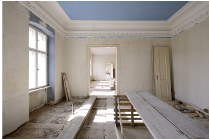
Das Museum im Wandel | Während der Umbauphase
