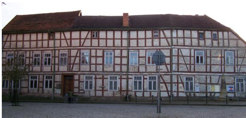
Hamburger Straße 49-2010 vor Sanierung
