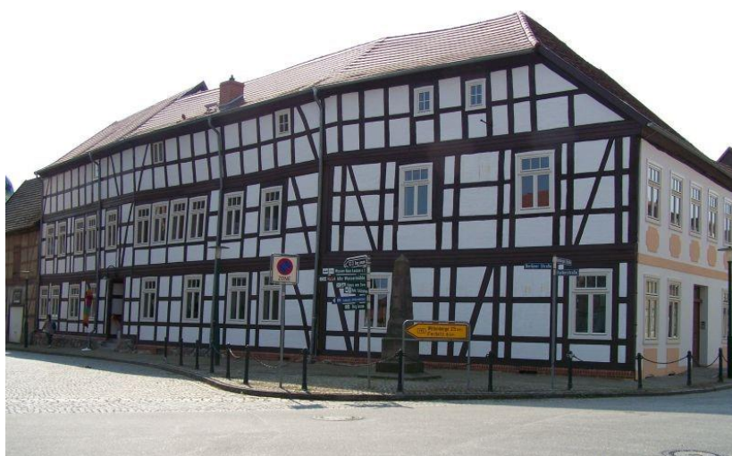
Hamburger Straße 49- 2015 nach Sanierung
