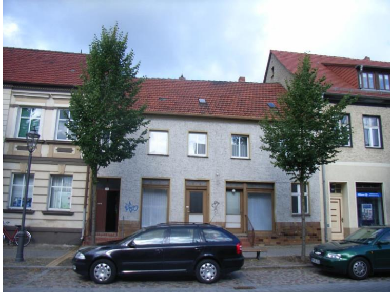
Berliner Str 200 vor Sanierung
