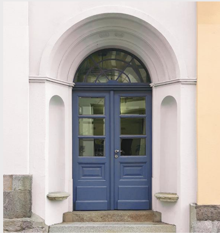
Das Sandsteinportal mit den Ziffern 101 und 136 über der Tür
