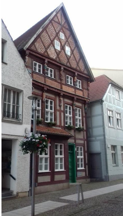
Bild nach Sanierung
