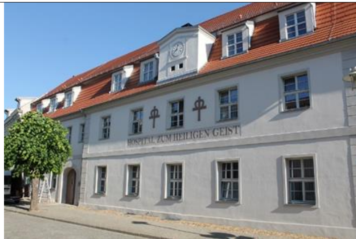
Bild nach Sanierung
