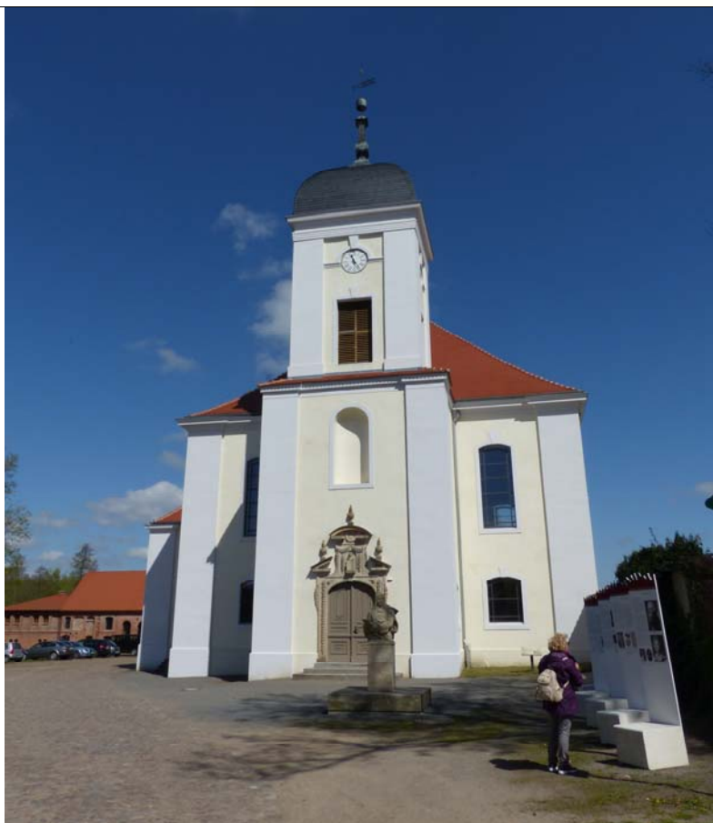
Bild nach Sanierung
