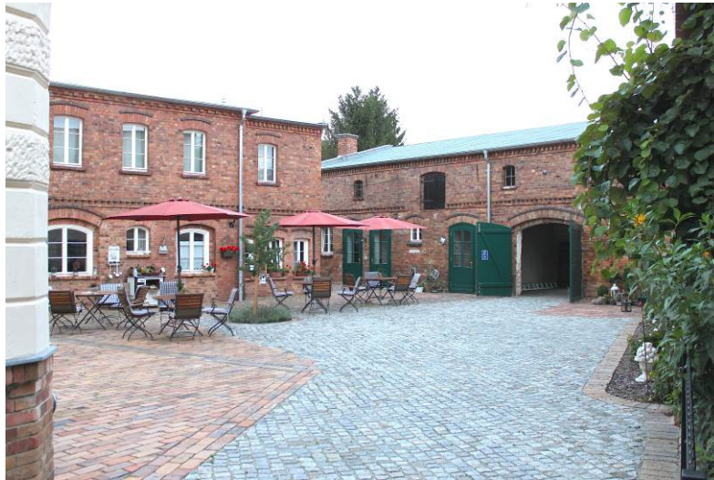
Der neu gestaltete Hof der Dammstraße 18 nach der Sanierung. Birgit Knabe und Frank Knabe, Eigentümer
