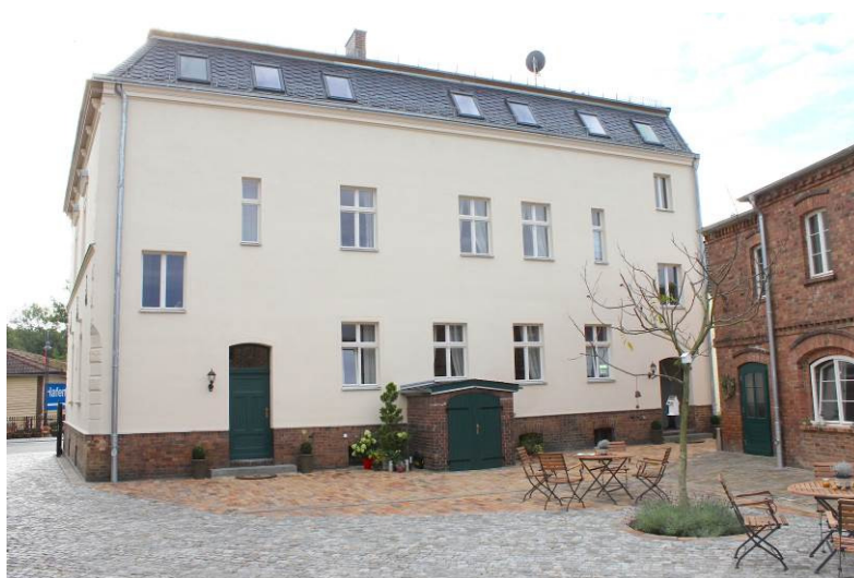
Die Rückseite der Dammstraße 18 nach der Sanierung. Birgit Knabe und Frank Knabe, Eigentümer
