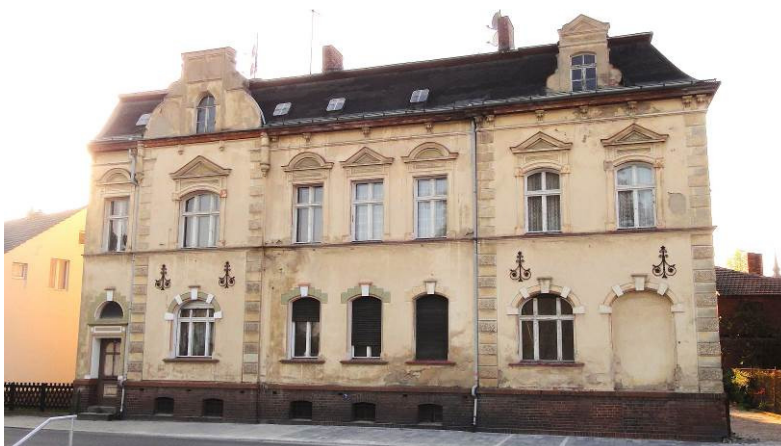
Die Vorderfassade der Dammstraße 18 vor der Sanierung.
