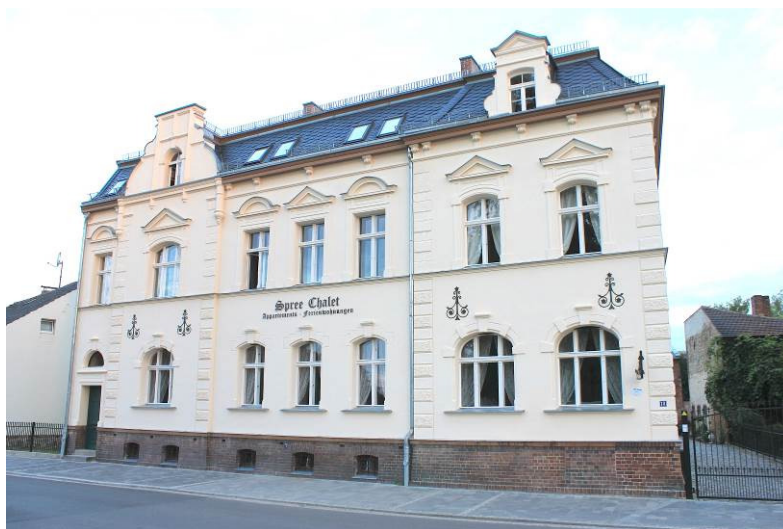
Die Vorderfassade der Dammstraße 18 nach der Sanierung. Birgit Knabe und Frank Knabe, Eigentümer
