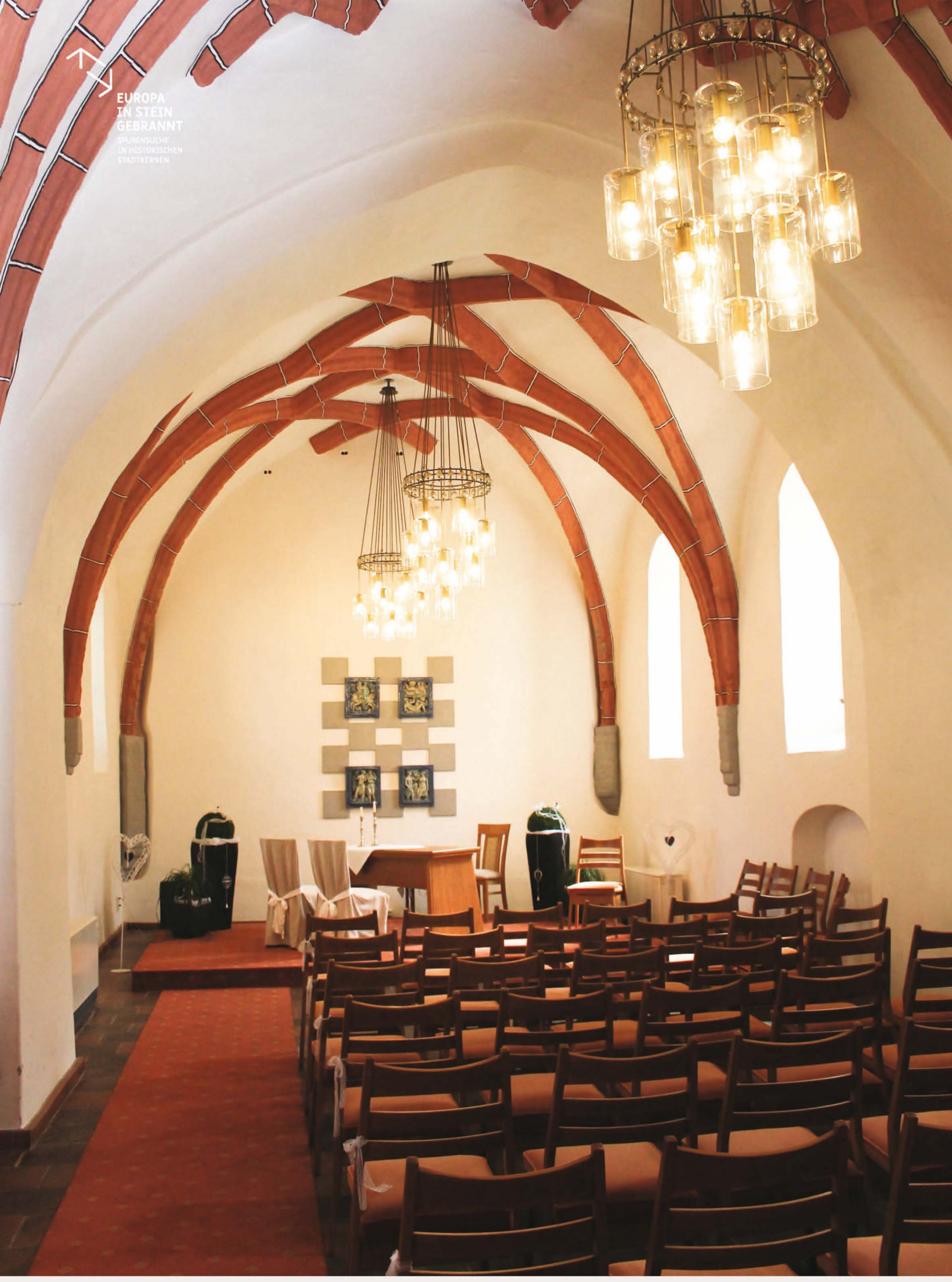
Den einschiffigen Innenraum hat man im späten 15. und im frühen 16. Jahrhundert eingewölbt, wobei das Netzgewölbe des Langhauses besonders ambitioniert ausgeführt wurde. Luckauer Maurermeister waren in dieser Zeit offenbar für ihre Gewölbe berühmt, wie das 1519 von Peter Heinrich aus Luckau ausgeführte Gewölbe in der der Bernauer Marienkirche belegt. Foto: Stadt Luckau
