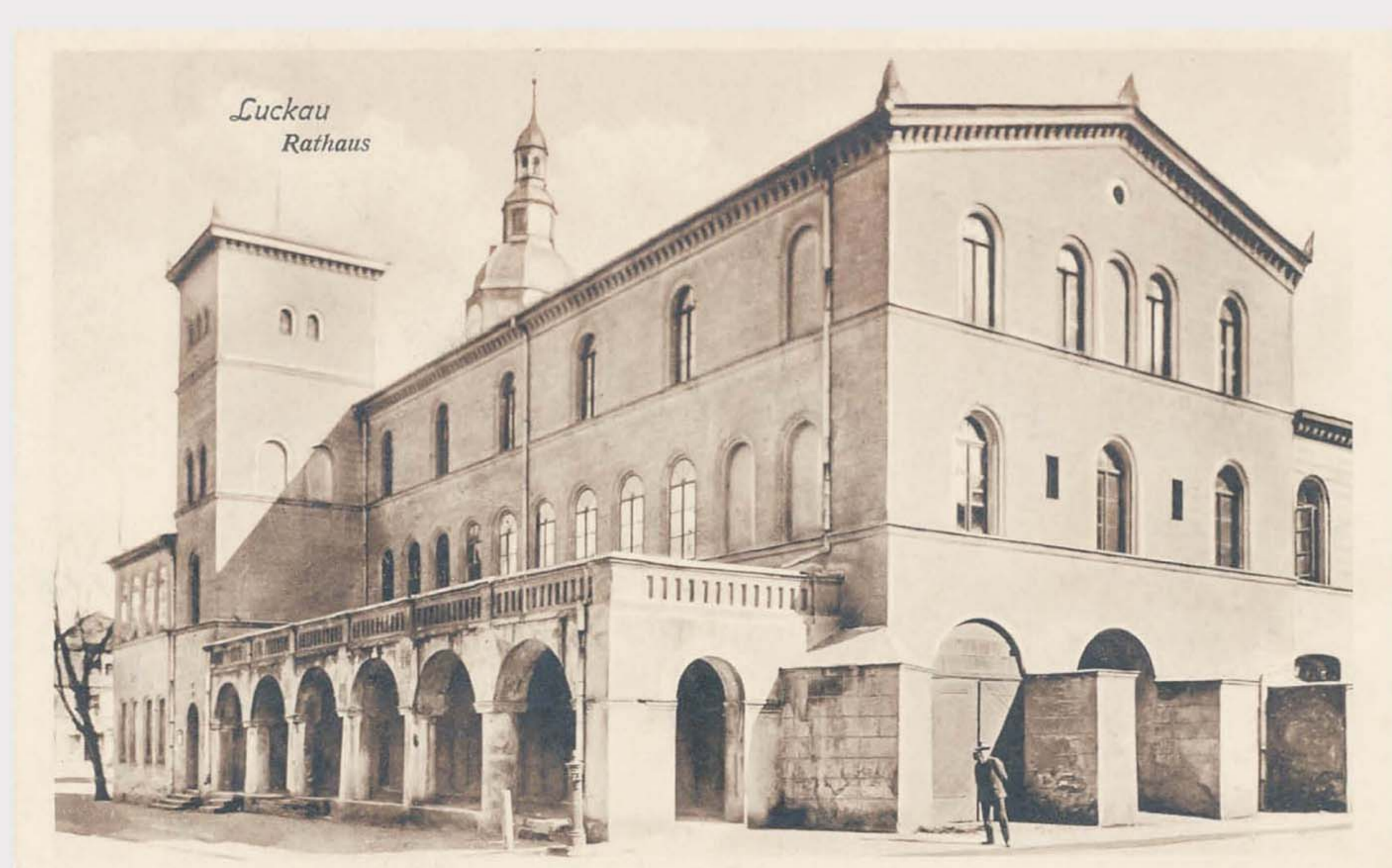
Historisches Foto der Nordfassade des Rathauses von 1917 mit offener Arkade. Ursprünglich dienten solche offenen Vorhallen an den Längsseiten der Rathäuser als Platz für Verkaufsstände.
