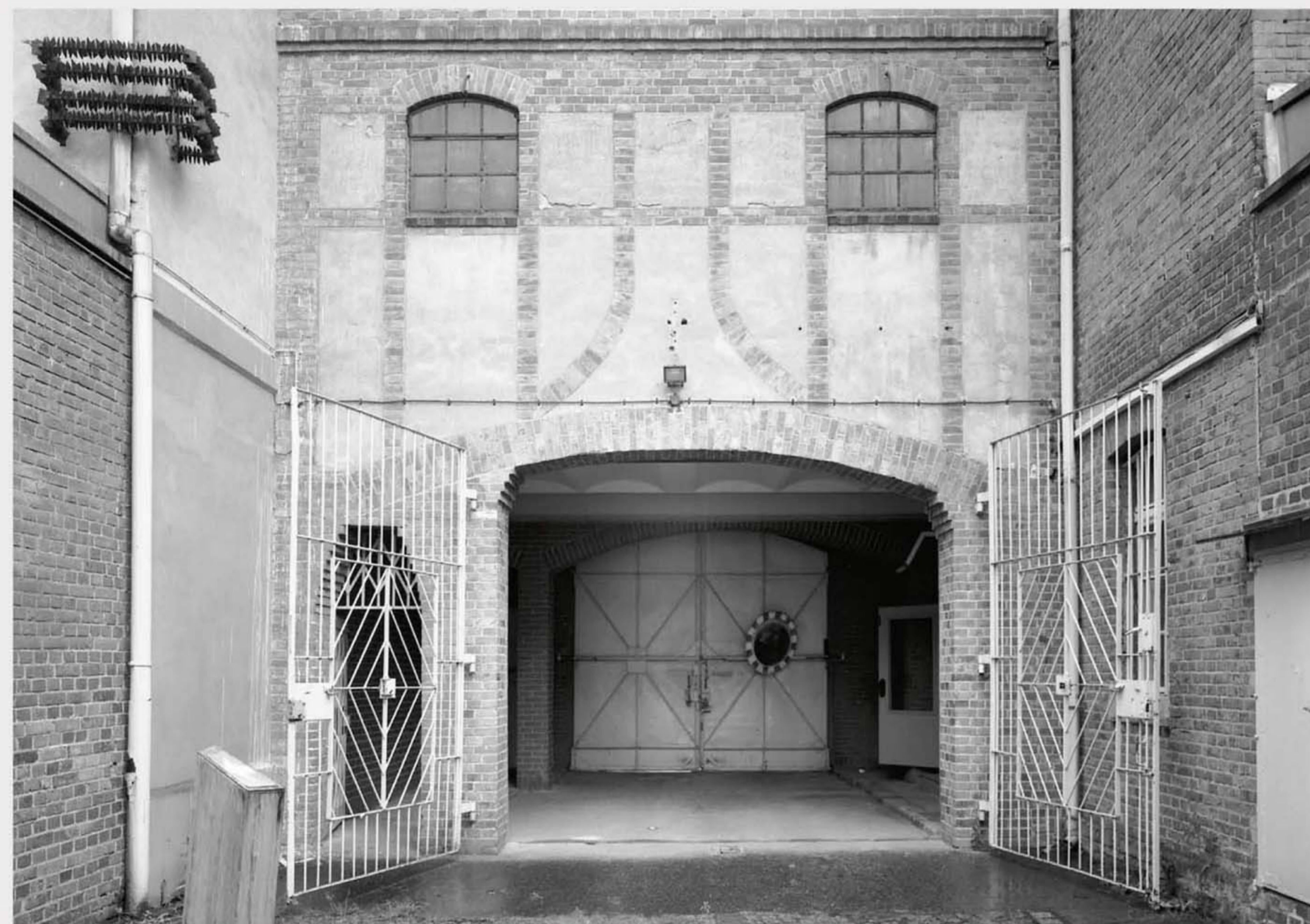
Ehemaliges JVA-Gelände vor Beginn der Sanierungs- maßnahmen, Zustand 2005. Fotos: Lorenz Kienzle, Berlin
