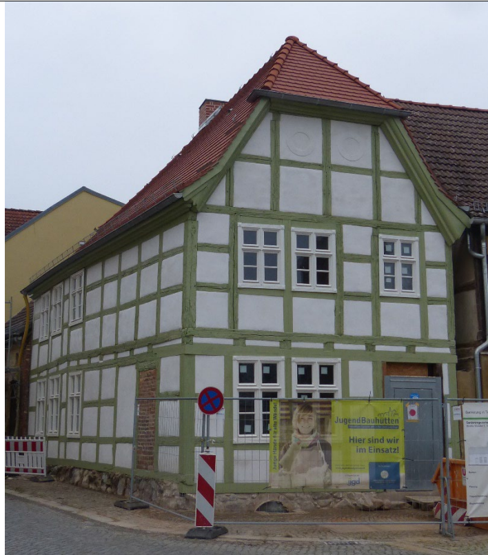
Bild nach Sanierung
