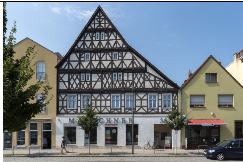
Bild nach Sanierung
