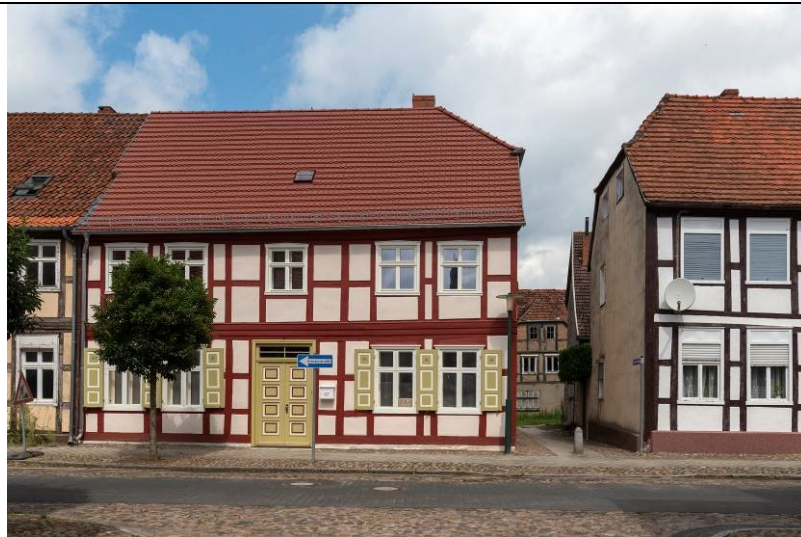
Bild nach Sanierung
