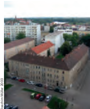
Wohnblocks in der Paulinerstraße vor der Sanierung, Blick vom Turm der Paulikirche zur Sankt-Annen-Straße
