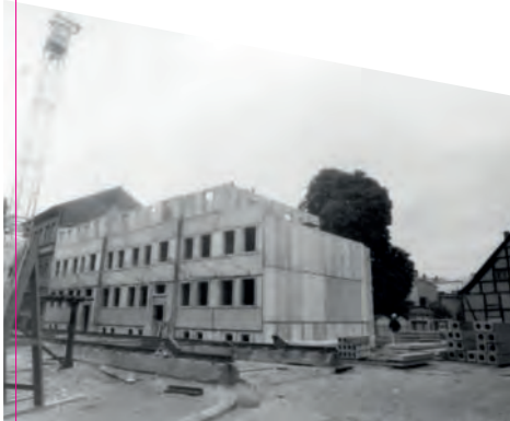
Neubau des Wohnhauses Katharinenkirchplatz 7-8 in angepasster Großplattenbauweise, Fertigstellung 1990
