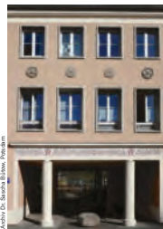
Wohnblocks in der Paulinerstraße nach der Sanierung, Fassadendetail 2020
