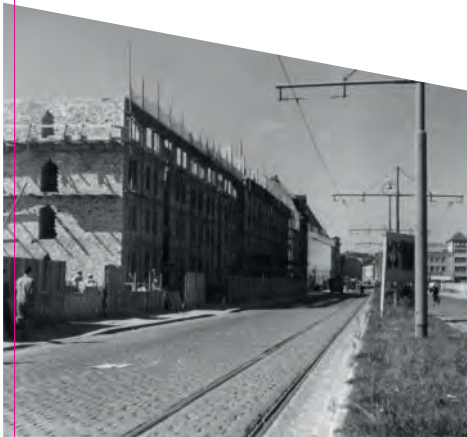
Brandenburg, Sankt-Annen-Straße, Wohnblöcke 1958 der Südseite im Bau. Traditionelle Backsteinbauweise in stark reduzierten Formen
