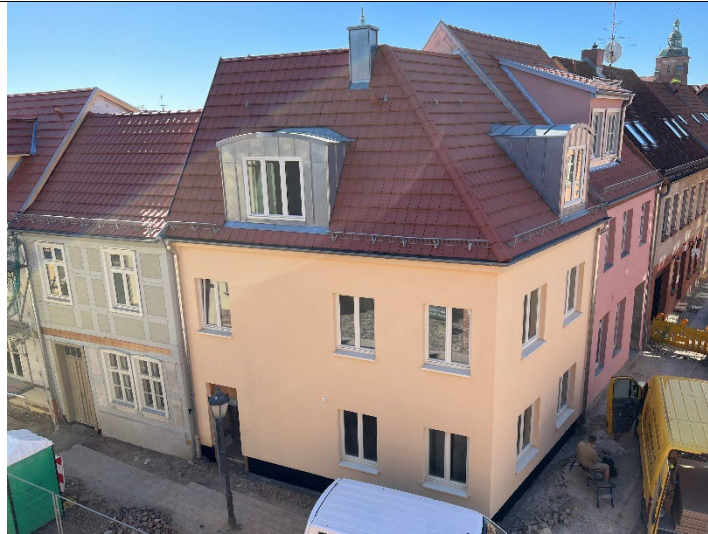
Bild nach Sanierung
